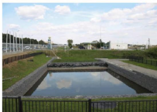
б) Пруд-отстойник каскадного типа
