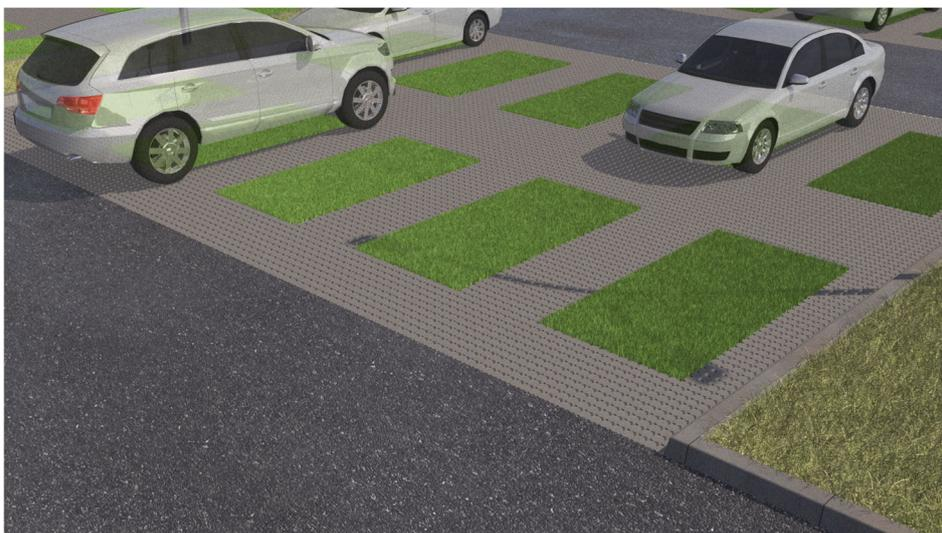
**Рисунок 6.12 – Пример укрепления грунта на грунтовых площадках для парковки автомобилей разными видами укреплений**
